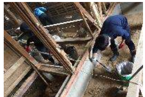
はがされた床の下にある土砂を撤去しました
