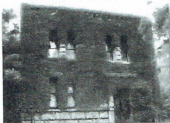
旧松山家住宅 松濤館 (芦屋市立図書館・打出分室) ★補完・解説版 P22. 23 参照
