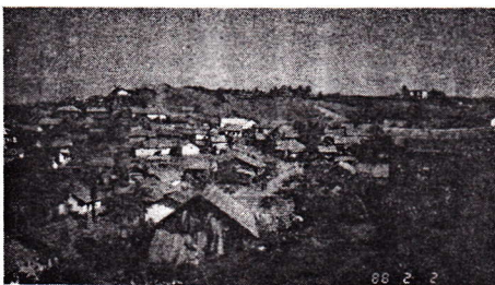
ジョウティー ナガールのスラム
