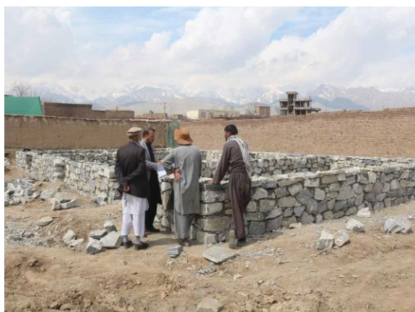
建設中の寺子屋（2017年10月完成予定）
