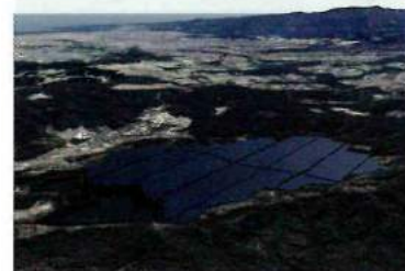
宮崎県における太陽光発電事業 年間発電容量は96.2MWと一般家庭3万世帯分の年間電力消費量に相当
