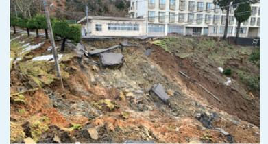
石川県立能登高等学校(柳田校舎)。寮前面の敷地が崩落し、地滑りが起きている
