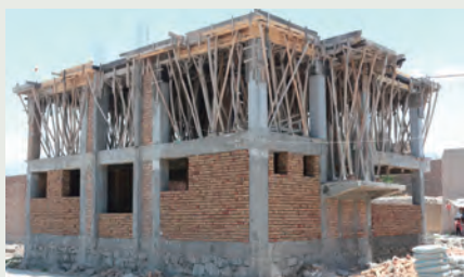
プロジェクト初の2階建ての寺子屋を建設中
