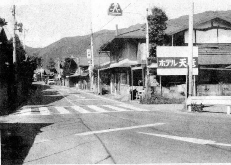
観蛸橋から駅陸橋方面を撮影、昭和55年10月13日 筆者撮影
