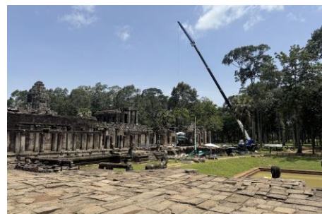
修復作業 をする人 たちとク レーン車
